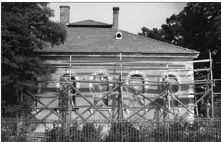
A Napraforgó Óvoda épület-rehabilitációja. * Fotó: Ady András
