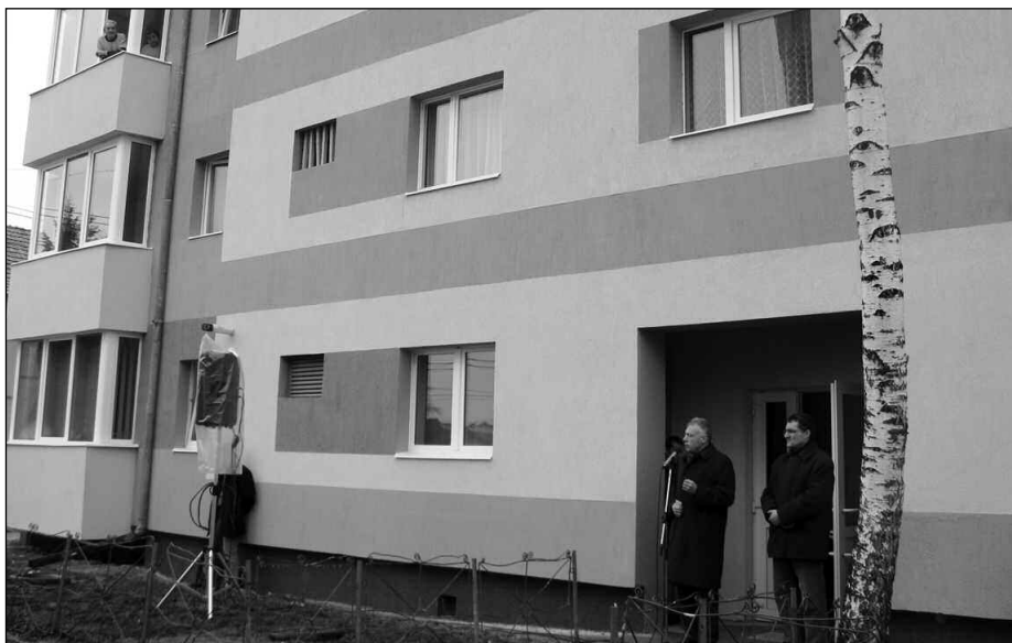
Ministrul Borbély László și primarul la recepția lucrărilor din str. Cântarului nr. 2.
